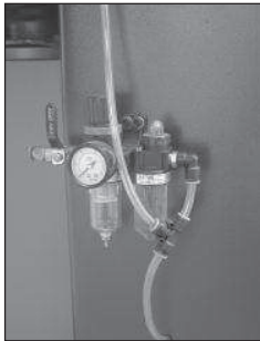
Druckluftanschluss mit Wartungseinheit
